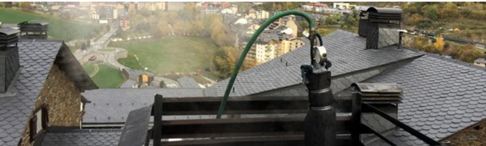
Sistema de **reparación de chimeneas rápido y fácil**. Permite la **rehabilitación sin la necesidad de obras de albañilería** en el edificio. La ejecución del sistema **Fitfire®** es la manera más fácil y rápida de renovar chimeneas, ya que sigue el conducto y se adapta a la forma de cada chimenea.
